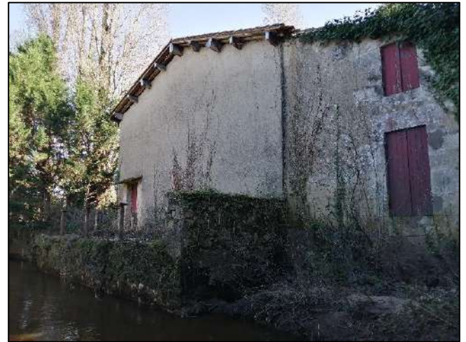
Photo 11 : Mur et bâtisse rive gauche à l'aval du pont Gambetta
