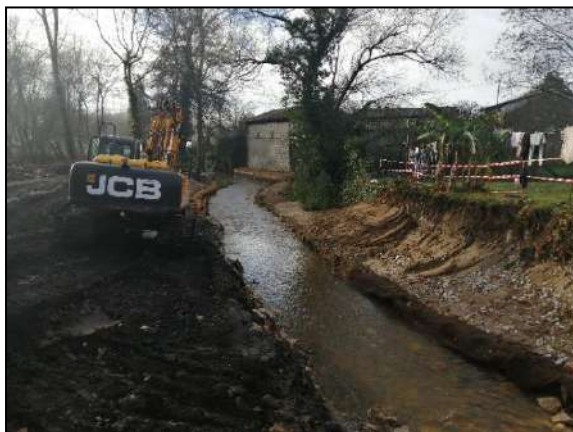
Photo 18 : Protection de berge en cours de réalisation
