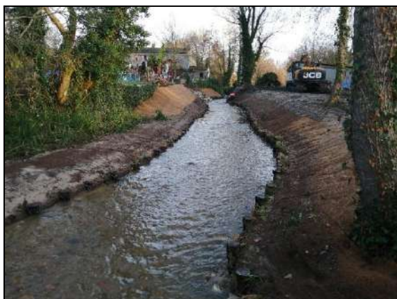
Photo 19 : Protection de berge réalisée - Chantier en cours de finition
