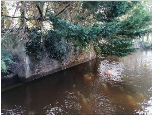
Photo 10 : Mur rive gauche à l'aval du pont Gambetta
