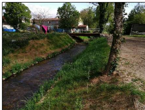
Photo 21 : Berge 1,5 mois après travaux
