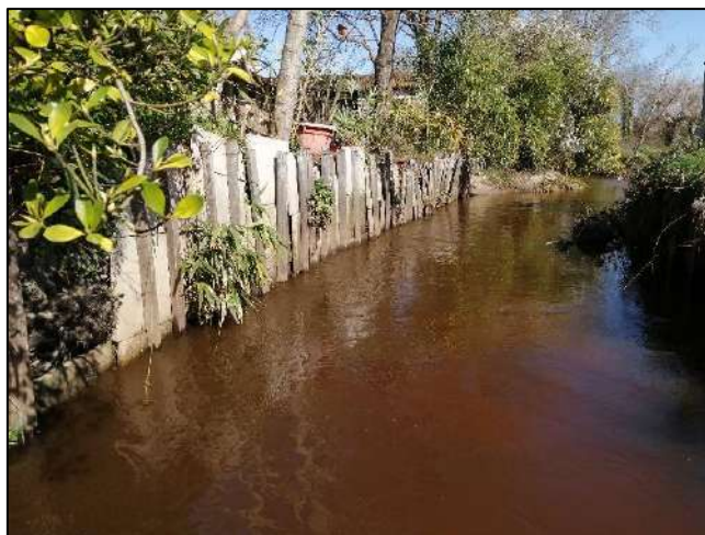
Photo 16 : Protection de type tunage en rive droite
