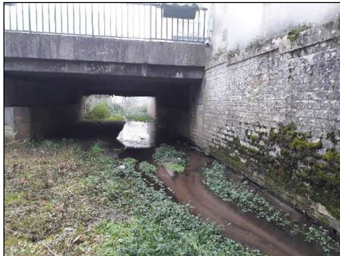
Photo 1 : Ruisseau des Martinettes sous le pont de la RD137
