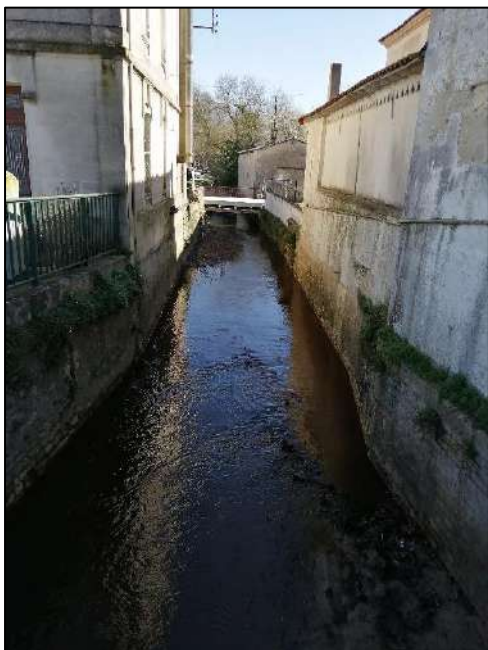
Photo 5 : Murs vers l'amont du pont de la D137
