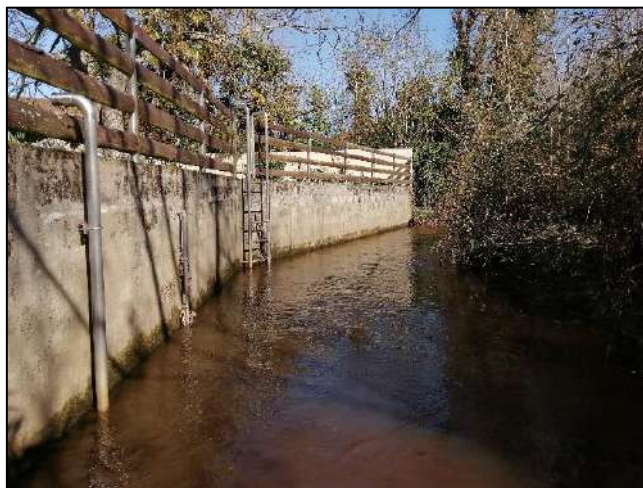
Photo 15 : Mur en rive droite
