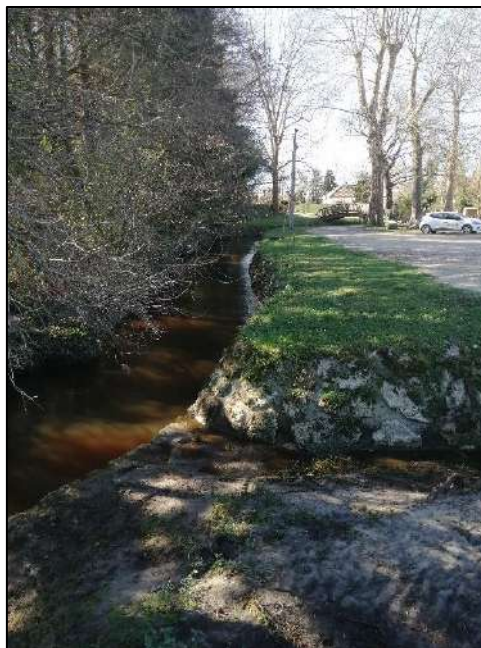
Photo 4 : Berge enrochée depuis l'aval immédiat de l'entrée de la Potence
