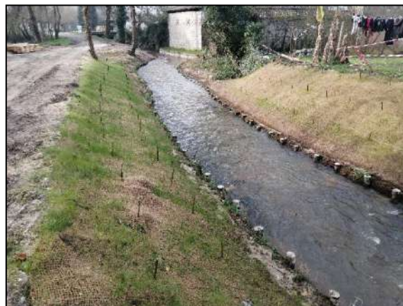
Photo 20 : Berge deux semaines après travaux
