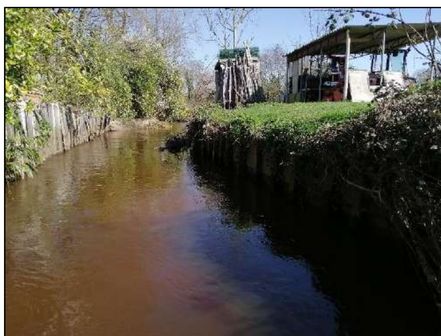
Photo 17 : Tunage bois en rive gauche
